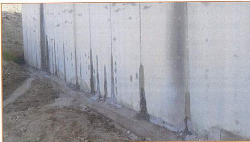
*Base de las placas taponada con mortero obturador.*
